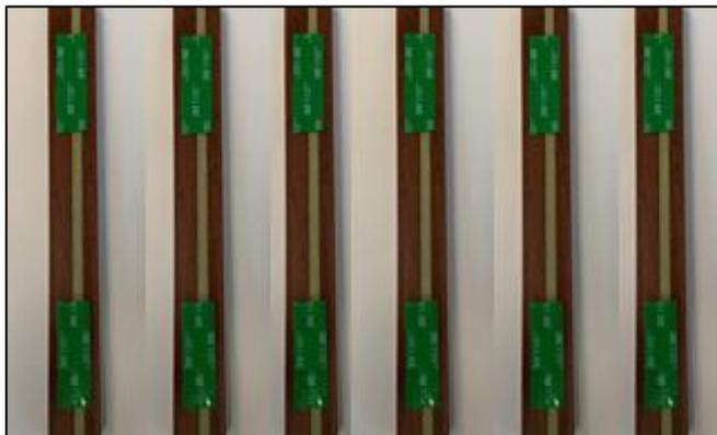
Após ter aparado as ripas nas medidas necessárias, aplicar no verso das ripas pedaços de fita dupla face (pedaços de 5 CM) em intervalos de até 40 CM (Caso o instalador prefira a fita poderá ser aplicada diretamente na parede). A Fita dupla face não precisa ser aplicada nos espaçadores.
