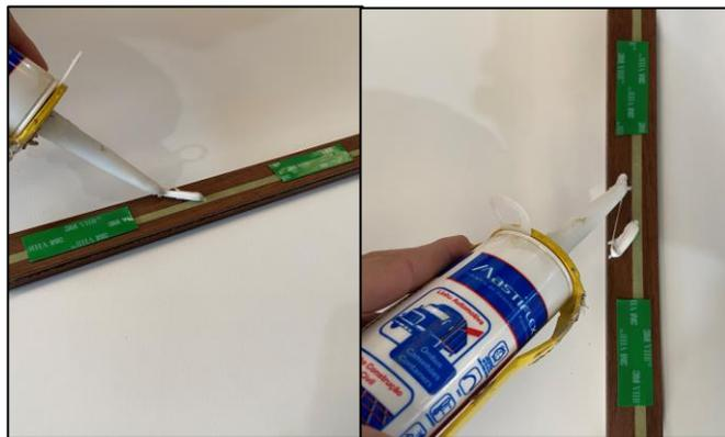
Após a colocação da fita dupla face aplicar a cola PU 40 entre os espaços das fitas e retirar a película das mesmas. A cola PU não precisa ser aplicada nos espaçadores.
