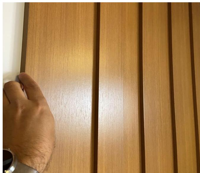
Este o resultado do painel ripado BARRETO após instalado em superfícies verticais. Para instalação do painel ou forro ripado no sentido horizontal deve-se consultar o fabricante BARRETO para maiores informações.
