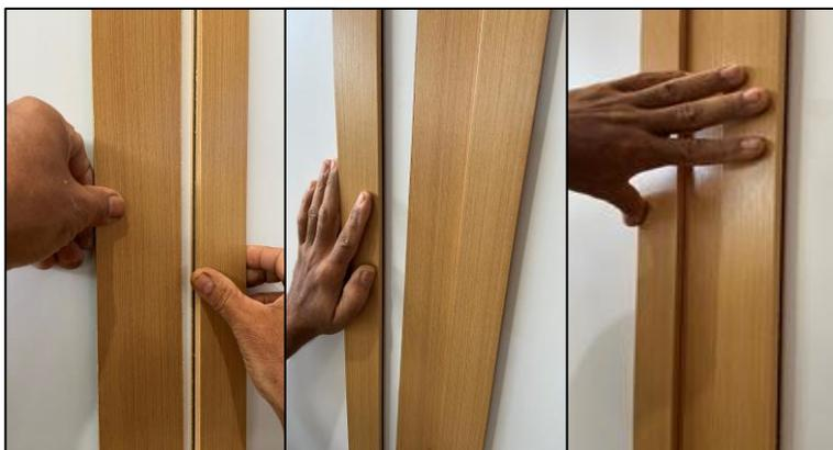
Após a aplicação da ripa na parede encaixe o espaçador na cavidade da ripa pressionando a mesma para que fique o mais firme e alinhado possível e continue aplicando as ripas e espaçadores sucessivamente até a medida necessária.
