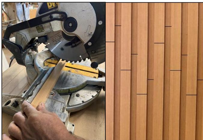
Após a limpeza e marcação da superfície aonde o ripado será instalado, deve-se efetuar o corte das ripas e espaçadores na medida desejada, caso a altura seja superior a medida máxima do painel (2,70 m) será necessário ser feita a emenda das ripas e espaçadores. A Barreto sugere que a mesma seja feita de forma desencontrada para que as emendas não fiquem tão perceptíveis.
