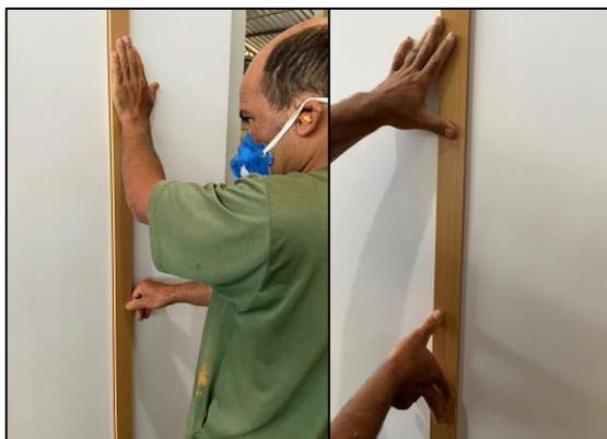
Coloque a ripa na posição de instalação e pressione contra a parede por um período de aproximadamente 30 segundos.
