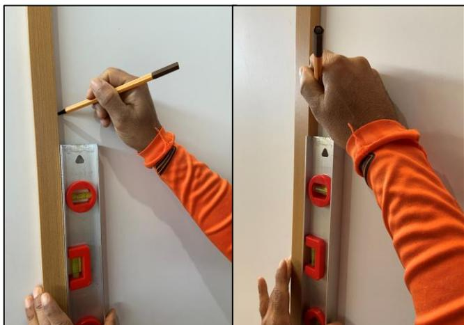
Primeiramente deve ser feita a limpeza da parede aonde o ripado será instalado. Após a limpeza, para facilitar e garantir que o posicionamento fique no alinhamento desejado sugerimos que seja marcado com o lápis e feito a marcação na parede.
